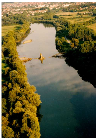
Srušeni most kod sela Brest
